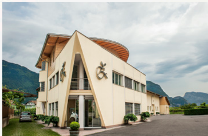
Cantina vini Peter Zemmer i Cortina huserar i en av de mest moderna vinaläggningarna i Sydtyrolen.
