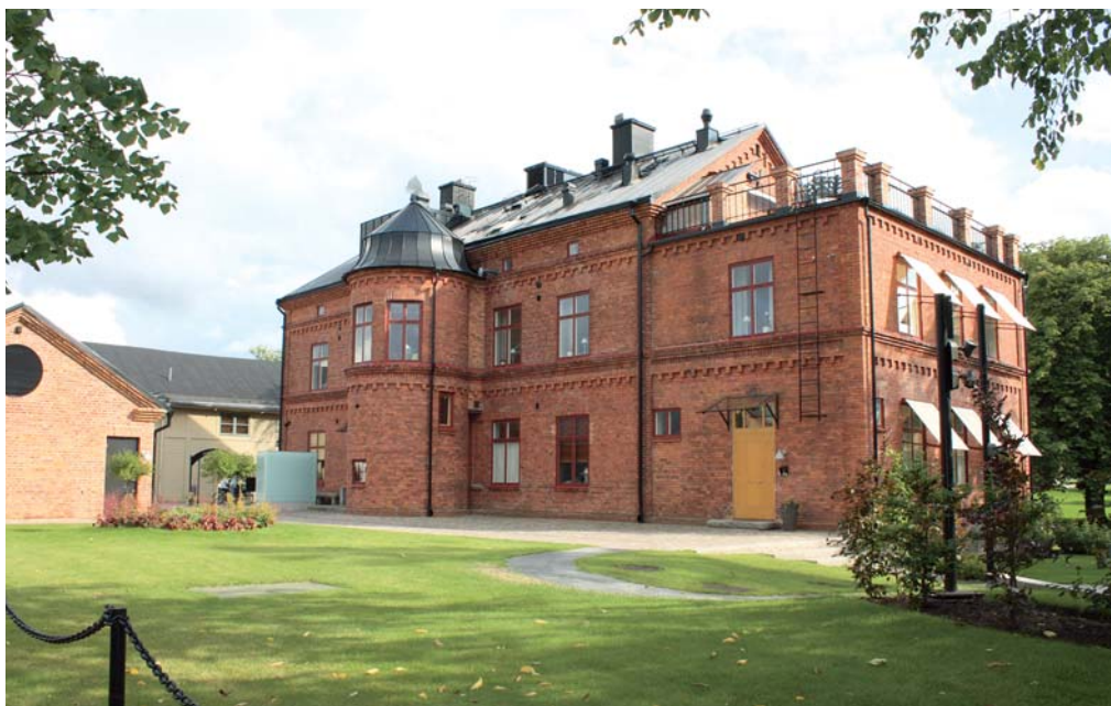
Det nya annexet byggs på utrymmet intill det befintliga gårdshuset (till vänster på bilden).
